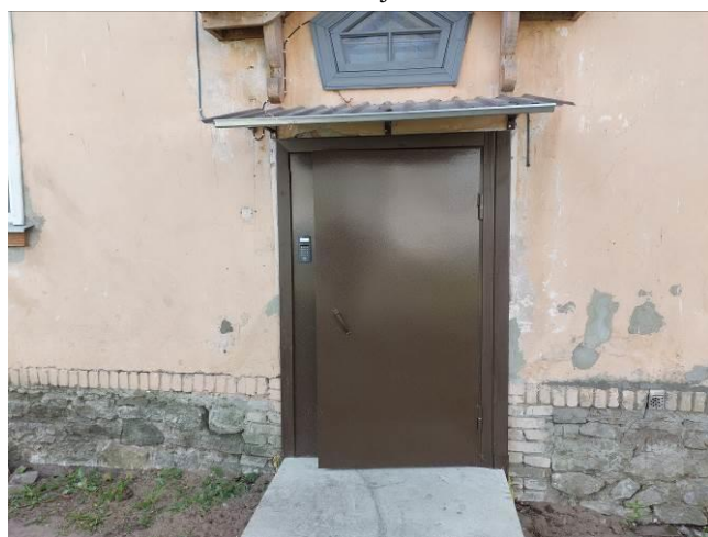
Skats uz kāpņu telpas durvīm
