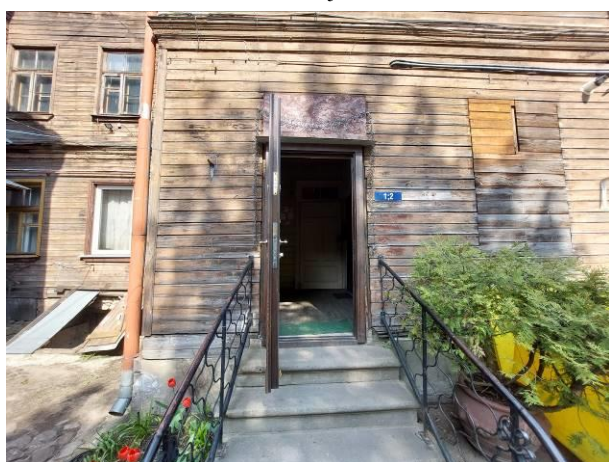
Skats uz kāpņu telpas durvīm
