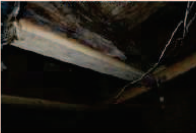
Attēls Nr. 48 Nesošajām koka konstrukcijām sākušies destruktīvie procesi (koksnes trupe, sēnītes parādīšanās)
