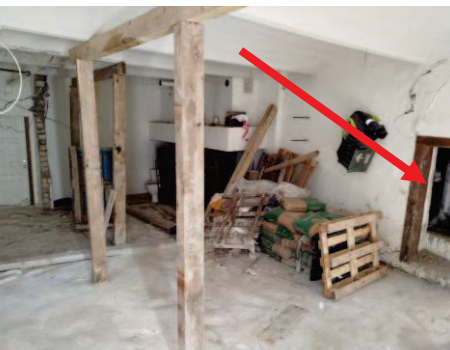
Izveidota piekļuve ēkas ārējiem inženiertīkliem - siltumtrase, būves stiprībai izveidotās koka konstrukcijas
